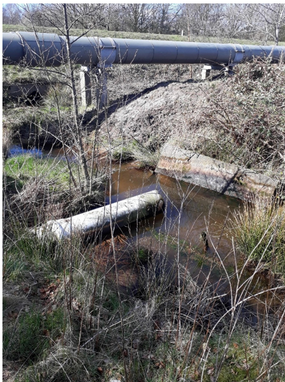
Figur 8 Umiddelbart inden Tarpbagevej, st. 1226 m, krydses bækken af gasledning. Her findes også et udløb, der pumper vand fra viadukten på Stjerneparkstien. Brinken overfor udløbet er sikret med et betonelement. Fotos: Sweco, marts 2020
