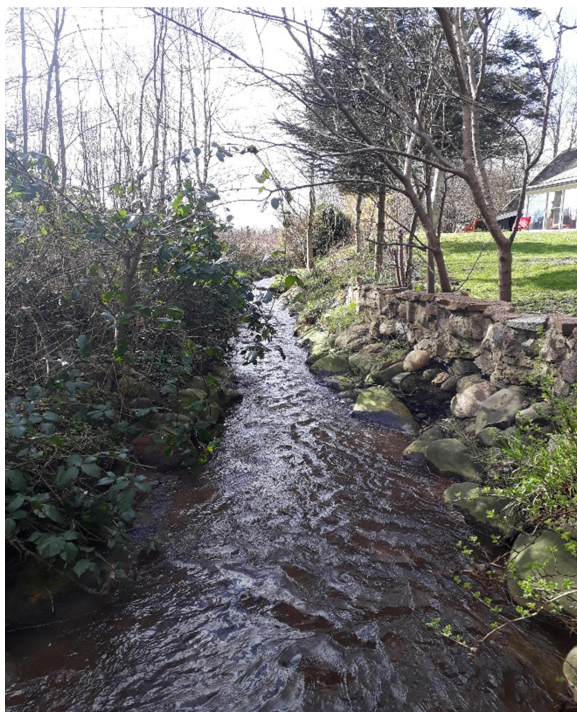
Figur 10 Tv.: Ved st. ca. 1020 m er vandløbet snævret ind med brinksikring i kampesten og stenet bund. Der er god strøm i vandet. Th. Nedstrøms denne strækning bliver vandløbet igen bredere med roligere strøm. Fotos: Sweco, marts 2020
